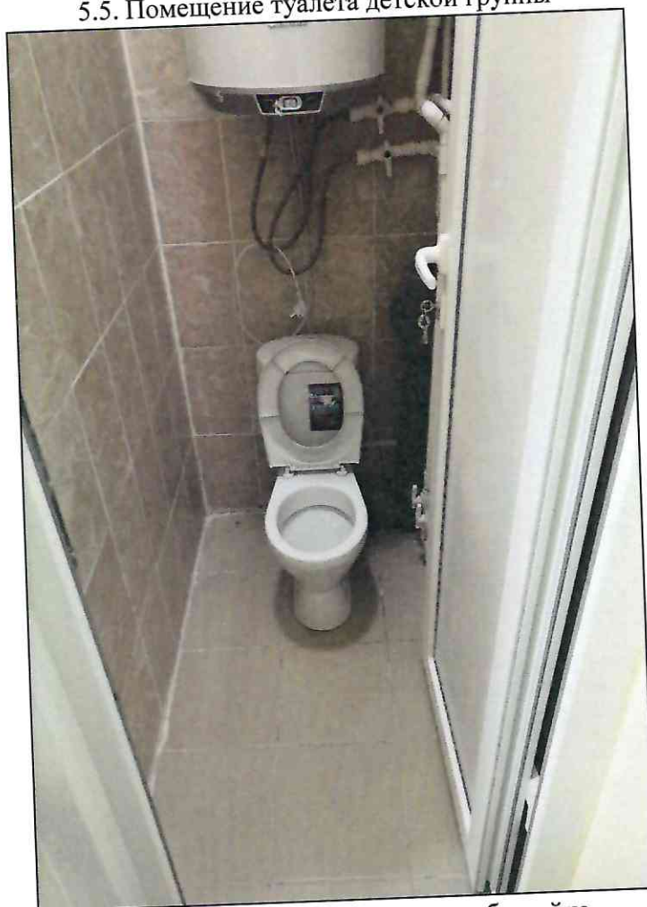
5.6. Дверь и помещение туалета бассейна
