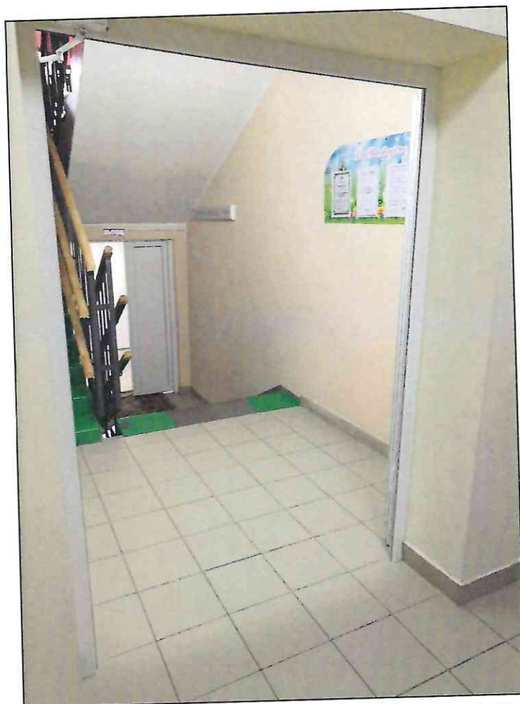
3.5. Дверь выхода на лестничную площадку первого этажа
