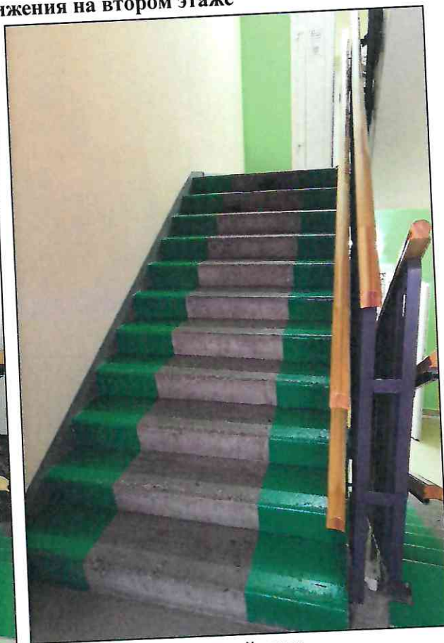
6.2. Лестница на второй этаж
